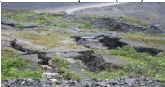
Hình 4. Sụt lún và nứt nẻ bề mặt khu vực trung tâm từ +200÷260m
