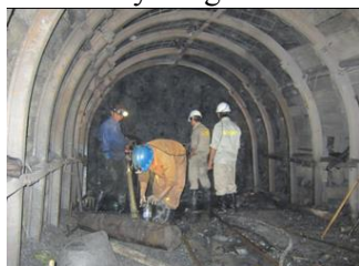
a. Thi công nạp nổ mìn
