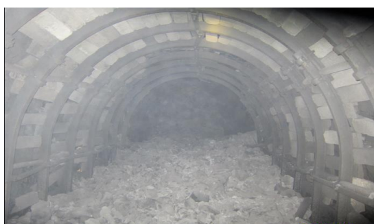
Hình 17: Hình ảnh kết quả sau một chu kỳ nổ mìn theo hộ chiếu đặt phá lăng trụ
