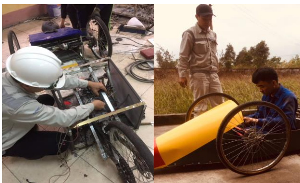
Hình 12. Quá trình chế tạo, lắp đặt xe sinh thái
