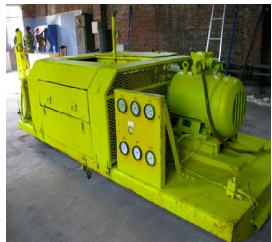
Hình 5. Trạm nén khí cao áp
